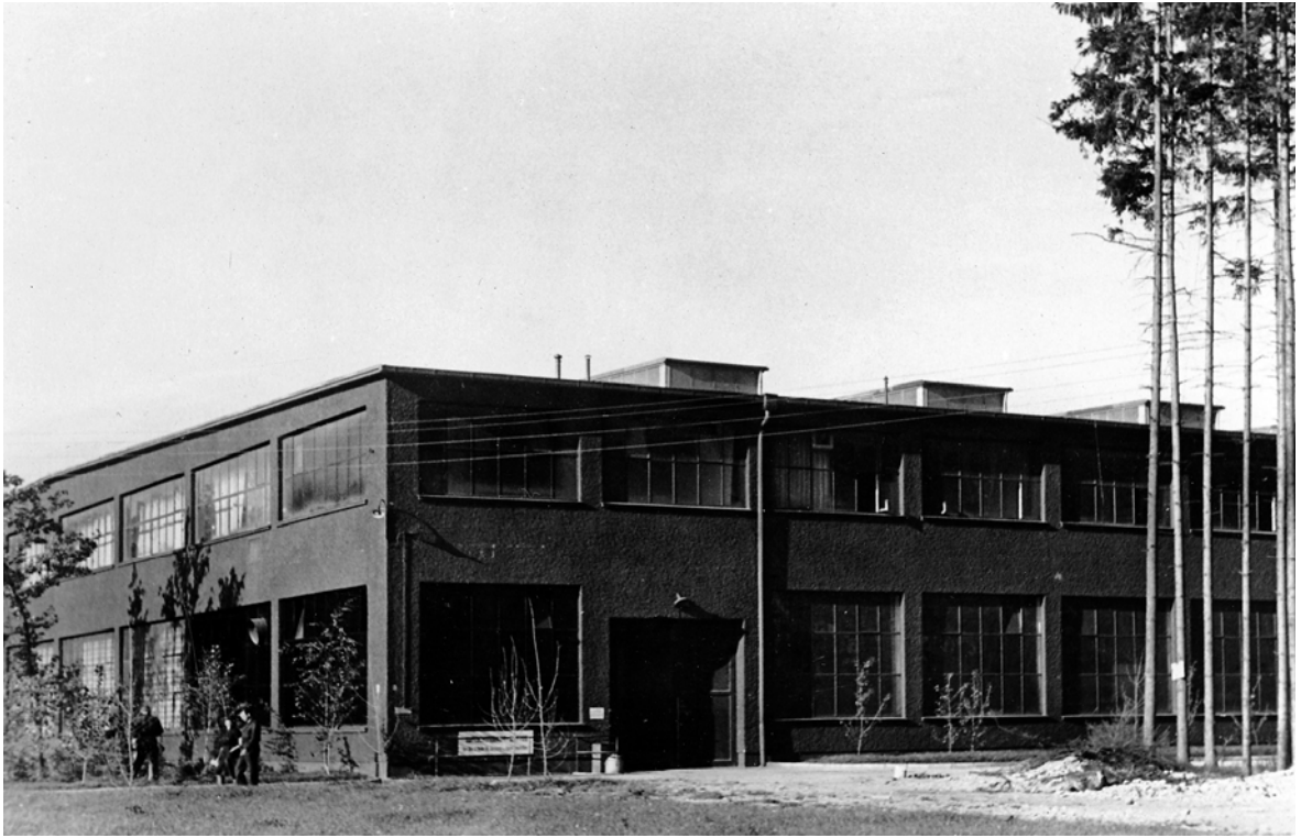
Die Halle VI war im Sommer 1943 bereits vollständig mit der dunklen Anstrichfarbe gestrichen. Ansicht der nordwestlichen Hallenseite. [Archiv ECS]
