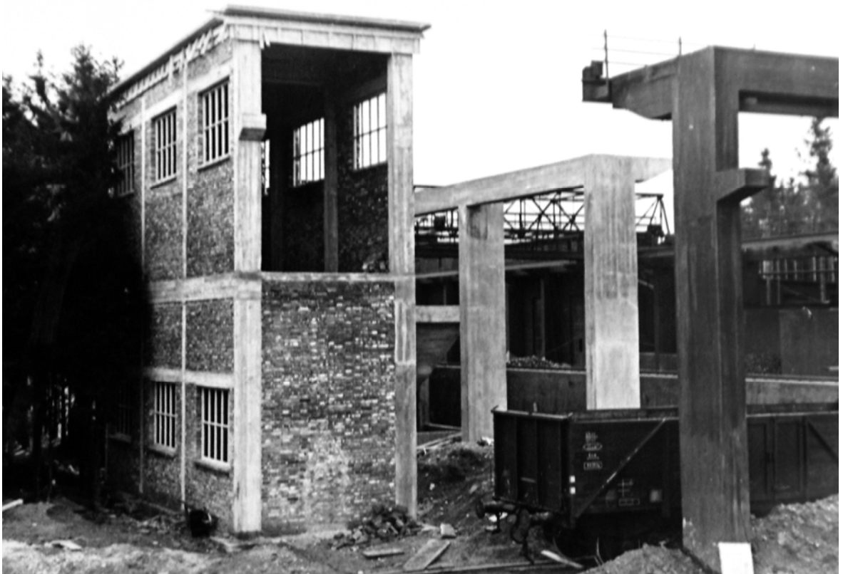
Der fertig gestellte und in Betrieb genommene Kohlenlagerplatz für das Kesselhaus im Sommer 1941. [Doku STV]
