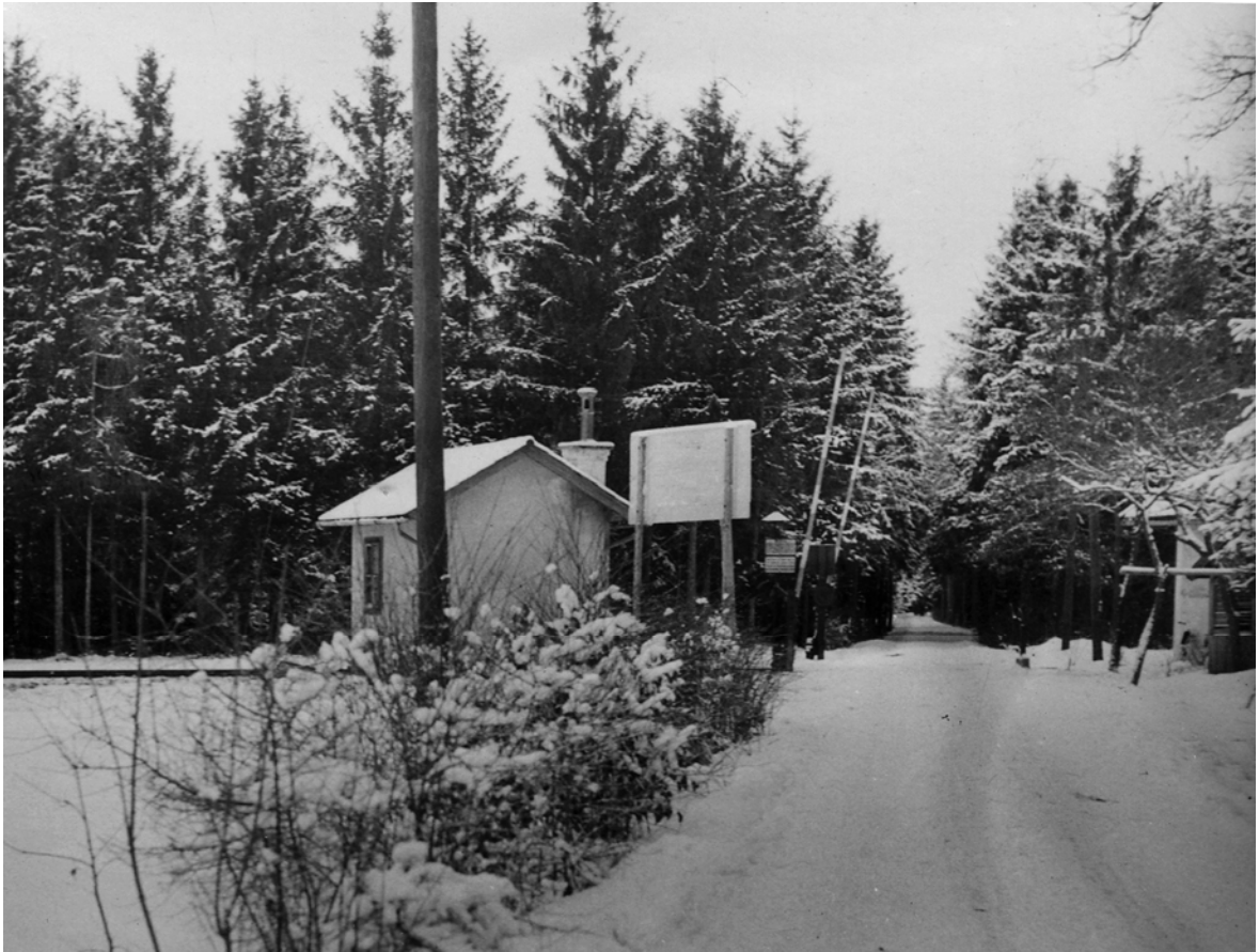
Diese Forststraße war bis zum Bau des Nibelungenwerks die Straßenverbindung vom St. Valentiner Ortsteil Langenhart nach Ernsthofen. Das Schild neben dem Schrankenwärtergebäude am Bahnübergang warnte vor dem unerlaubten Betreten der Baustelle. [BFSTV]
