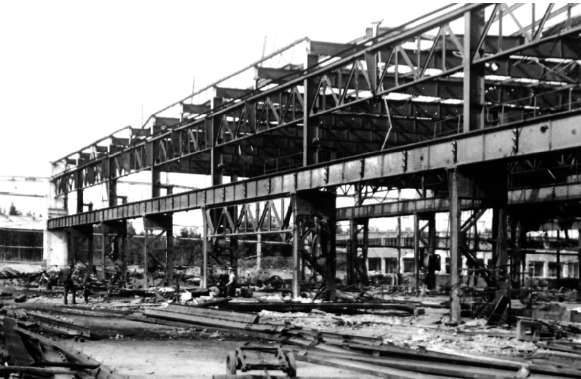
Die Halle VII wurde nach der Halle V ebenfalls komplett demontiert. Rechts im Hintergrund war zum Aufnahmezeitpunkt noch die Halle VIII zu sehen. [Doku STV]
