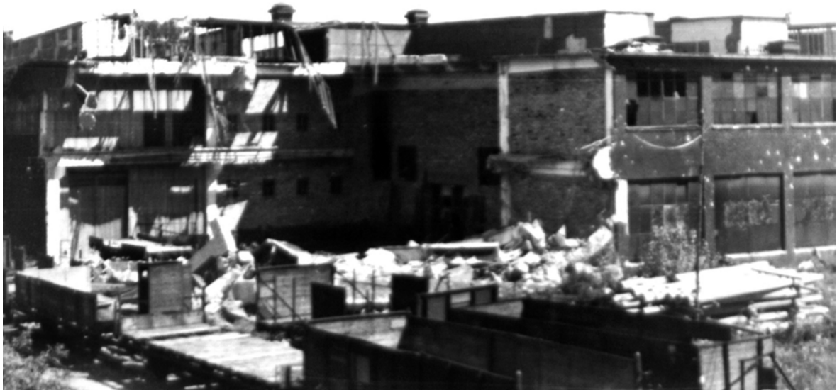
Von allen Hallen war die Halle IV bei Kriegsende am wenigsten beschädigt. Nur die nordwestliche Eckseite war durch einen Bombentreffer zerstört worden. [Doku STV]
